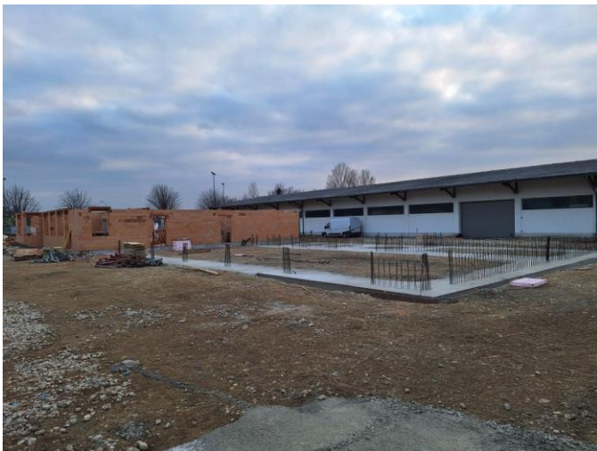
Die Ziegelmauern im Erdgeschoss stehen. Und die Fahrzeughalle wird auch schon für die Anlieferung der Betonfertigelemente vorbereitet.
