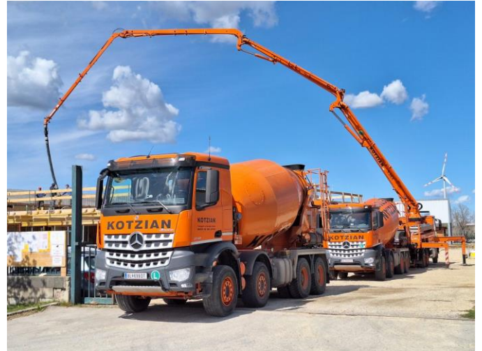
Es wird wieder betoniert - zuerst die Hohlwände, danach die Erdgeschossdecke.
