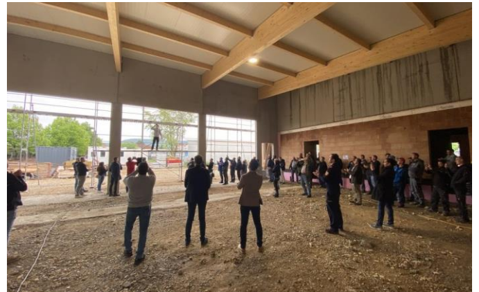
Gleichenfeier – eine Tradition! Der Richtspruch wurde gesprochen und ein Glas zerbrochen. Bei Speis und Trank dankte man allen Baustellenarbeitern für die bisher erbrachten Leistungen.
