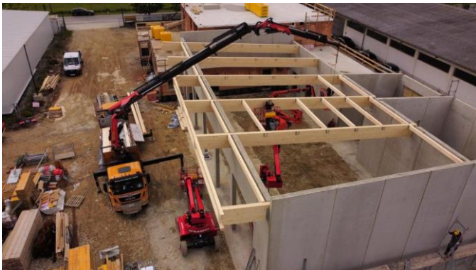
Das schlechte Wetter hat zu einer kleinen Verzögerung geführt, aber heute war es so weit – der Holzbau in der Fahrzeughalle wurde geliefert und wird sofort montiert.
