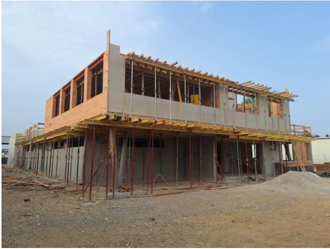
Auch das Obergeschoss vom Verwaltungsgebäude wird binnen weniger Tage aufgestellt. Spätestens jetzt erkennt man die Außenkontur vom neuen Feuerwehrhaus.
