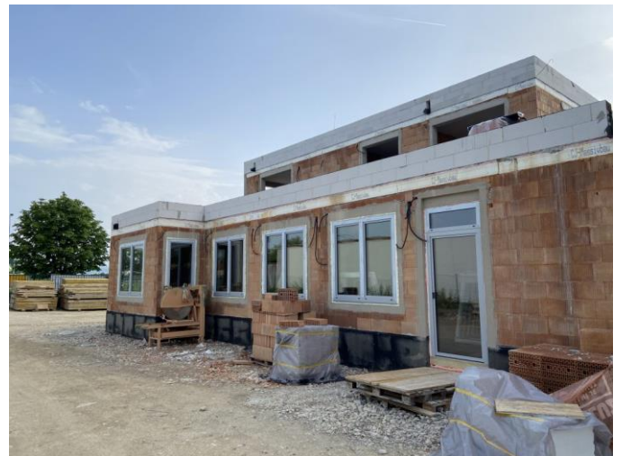
Die Fenster sind geliefert und werden auch gleich eingebaut. Optisch sieht es schon recht gut aus.
