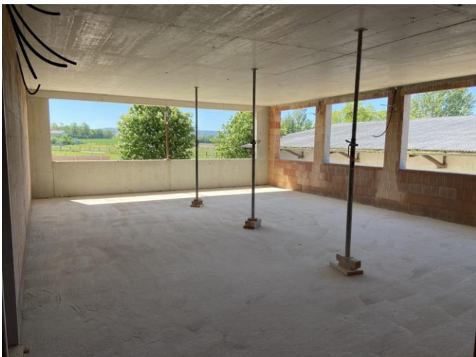
Unsere Eigenleistungen definieren sich unter anderem auch im regelmäßigen Aufräumen der Baustelle. Kräfte-raubend, aber die Stimmung war immer sehr gut. Hier ein erster Blick in das Gebäudeinnere, nämlich in den zukünftigen Schulungsraum. Besenrein!
