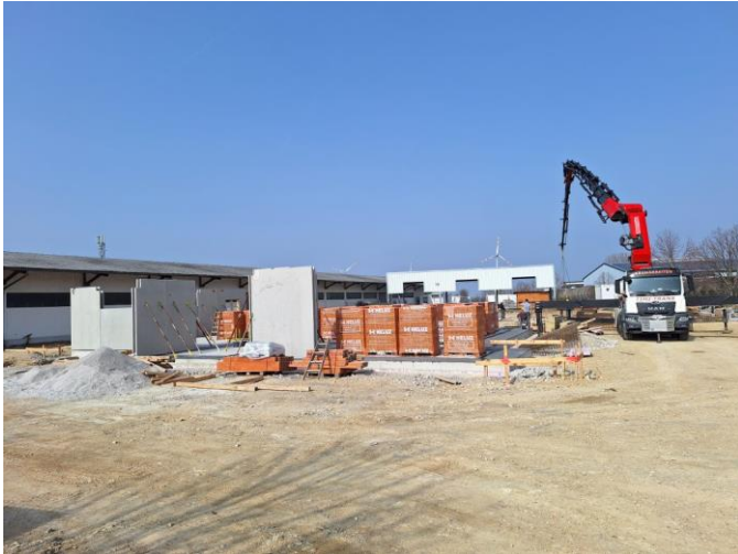
Die ersten Betonfertigelemente für das Verwaltungsgebäude wurden geliefert und aufgestellt. In den folgenden Tagen wird das Verwaltungsgebäude in Ziegel Massivbauweise aufgebaut.
